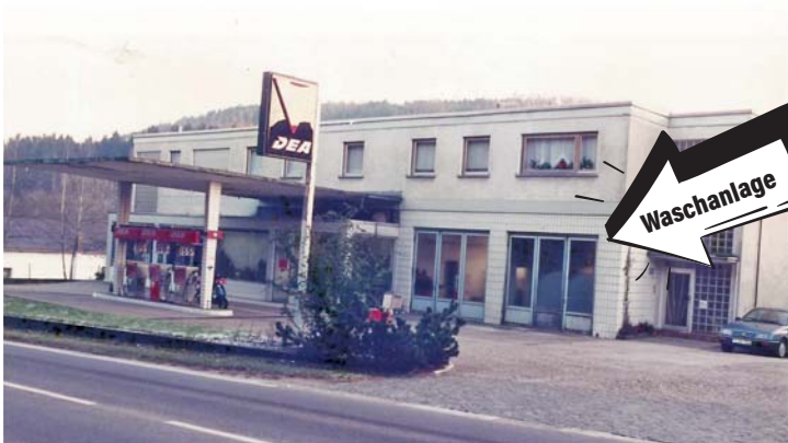
Tankstelle Horn in den 1990ern
